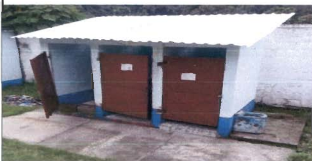
Foto 11: Módulo 2: Sustitución de puertas de servicios sanitarios.
