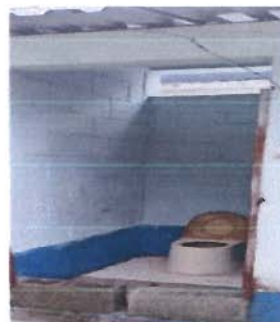
20. Foto: Módulo 2: Sustitución de inodoro.
