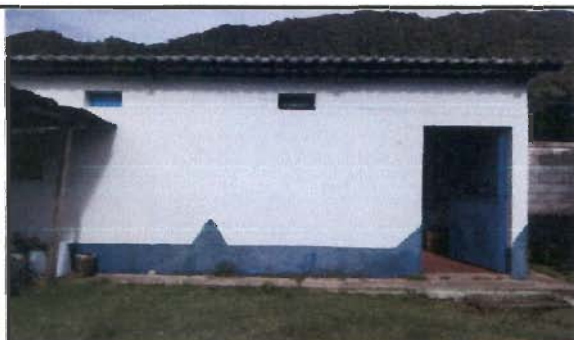
21. Foto: Cocina: Pintura en muro interiores y exteriores.
