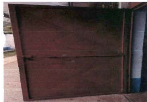
Foto 12: Módulo 2: Mantenimiento a estructura de metal (lijado, cambio de tubo, cepillado, sujeciones, aplicación de pintura. Sustitución de chapa.
