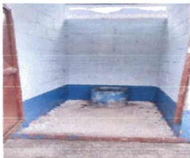
19. Foto: Módulo 2: Sustitución de inodoro.
