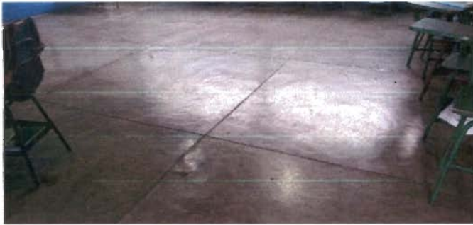
Foto 15: Módulo 2: Sustitución de torta de concreto por cerámico.
