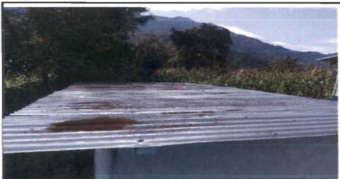
Foto 3: Baños modulo 1: Sustrución de lámina por lámina troquelada Aluzinc calibre 26.
