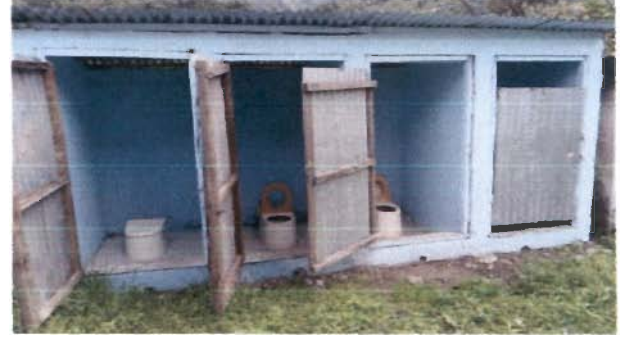
Foto 8: Módulo 1: Sustitución de inodoro.
