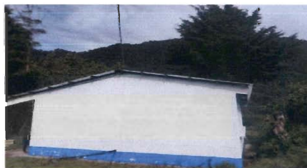
22. Foto: Módulo 3: Pintura en muros interiores y exteriores.
