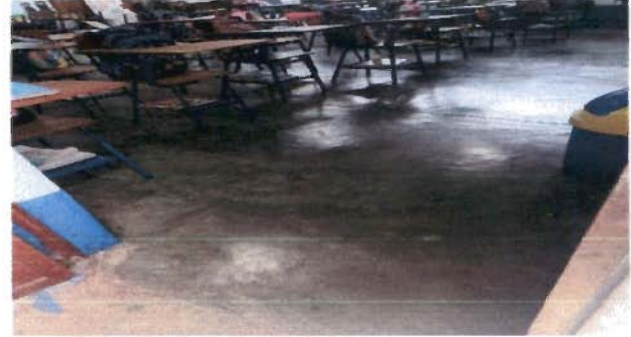
Foto 14: Módulo 2: Sustitución de torta de concreto por cerámico.
