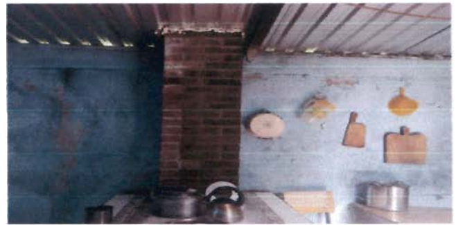
26. Foto: Repello de muro en cocina interior y exterior
