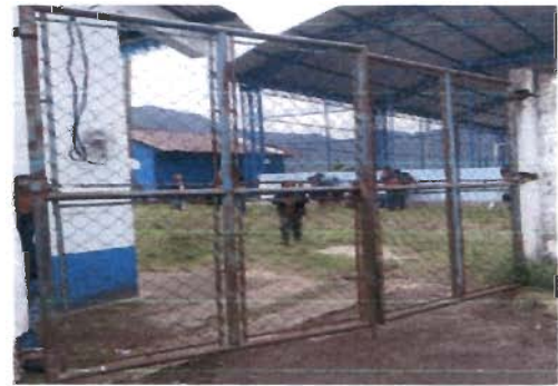
Foto 10: Sustitución de portón de metal.
