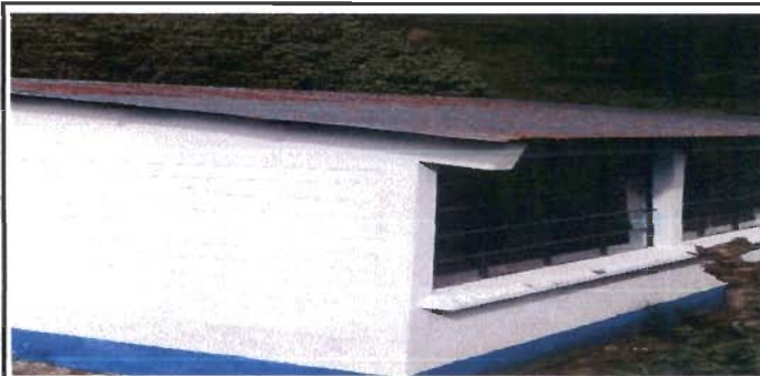
Foto 2: Modulo 3: Sustrucion de lamina por lamina troquelada Aluzinc calibre 26, sustitucion de elementos de fijacion. Sustrucion de capote de lamina para lamina troquelada.
