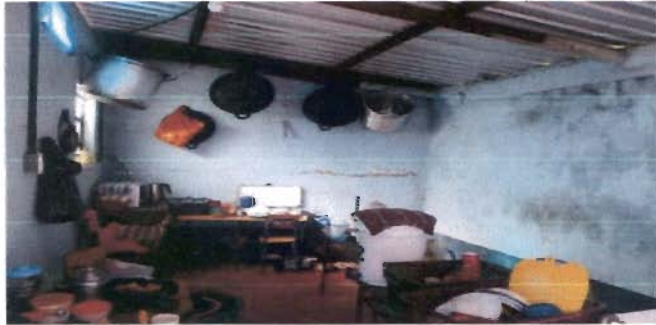
25. Foto: Repello de muros en cocina interior y exterior
