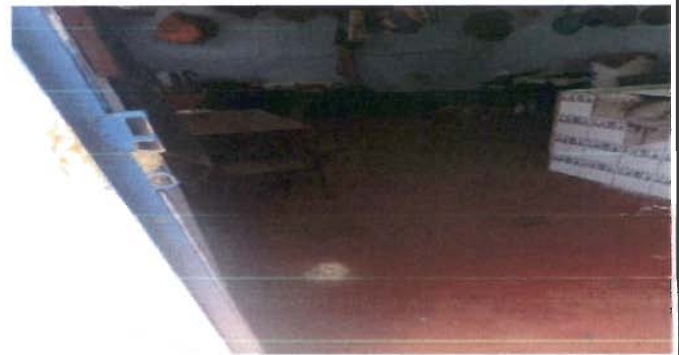
Foto 16: Cocina: Sustitución de torta de concreto por cerámico.
