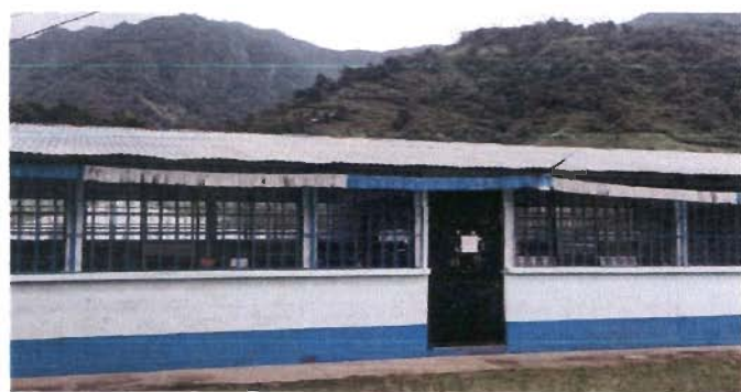
Foto1: Modulo 1: Sustrución de lámina por lámina troquelada Aluzinc calibre 26, sustitucion de elementos de fijacion. Sustrución de capote de lámina para lámina troquelada.
