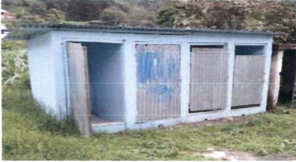
Foto 7: Módulo 1: Sustitución de puertas en servicios sanitarios.
