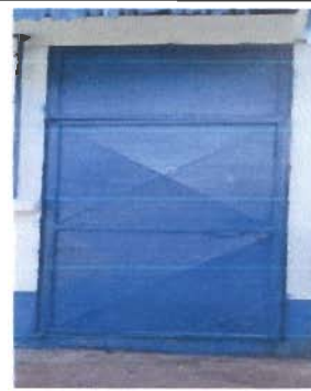
Foto 6: Modulo 1: Sustrución de chapa.
