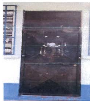
Foto 4: Modulo 1: Mantenimiento de estructura (lijado, cambio de tubo, cepillado, sujeciones, aplicacion de pintura).
