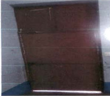
Foto 13: Módulo 2: Mantenimiento a estructura de metal (fijado, cambio de tubo, cepillado, sujeciones, aplicación de pintura).
